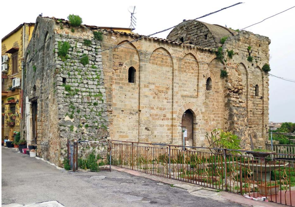
Fig. 7 Uscibene, il lato esterno della cappella con le archeggiature ogivali cieche
